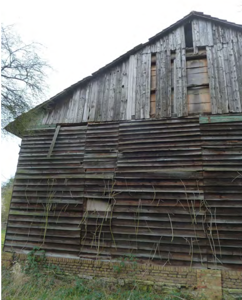
Abb. 8: Scheune auf Flurstück 45; Giebelwand mit Öffnungen zu Fledermausquartier
