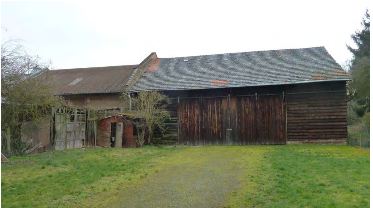
Abb. 7: Scheunen im Norden des Plangebiets (Flurstücke 42/1 und 45)
