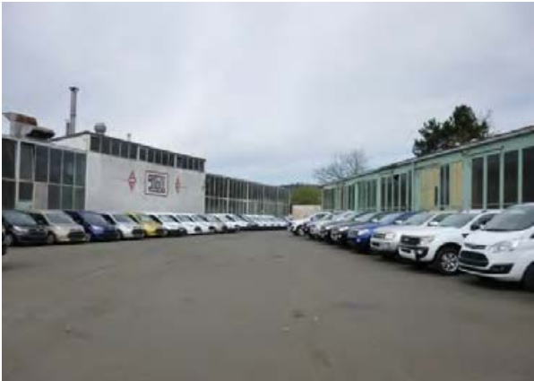
Blick zwischen die Hallen im nördlichen Teil des ehemaligen Betriebsareals
