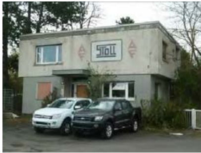
Ehem. Wohnhaus/Büro, im Norden des Areals
