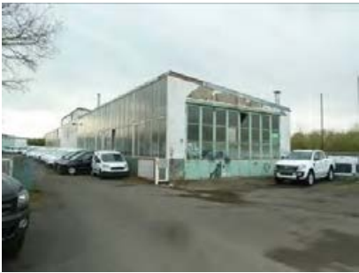
Ehem. Lackierhalle, zentral im Geltungsbereich
