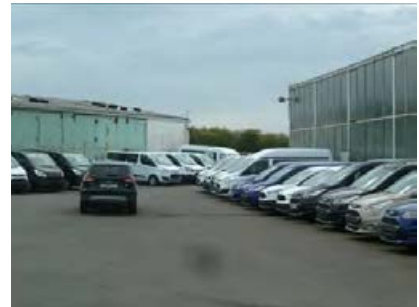
Gebäudebestand (links Montagehalle Süd, rechts Lackierhalle)
