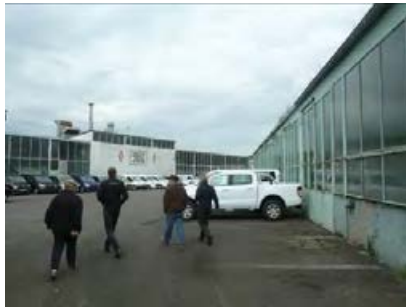
Gebäudebestand (links Lackierhalle, rechts Montagehalle Nord)
